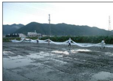
ビニール敷設作業 (手作業)
